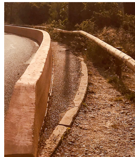
Muret de protection pour les piétons
