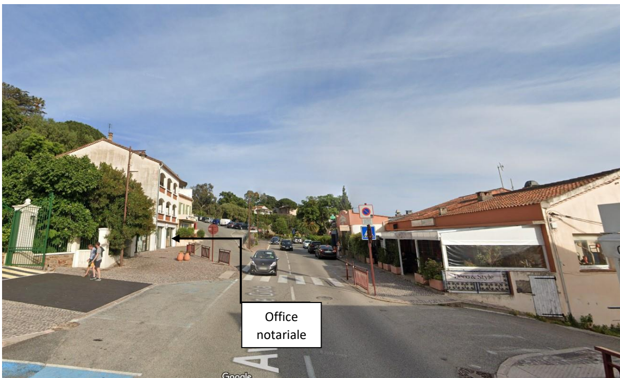
Façade nord de l'av. Etienne Gola en avançant vers l'Est : l'office notariale en rez-de-chaussée est surélevée de 2 étages de logements.
