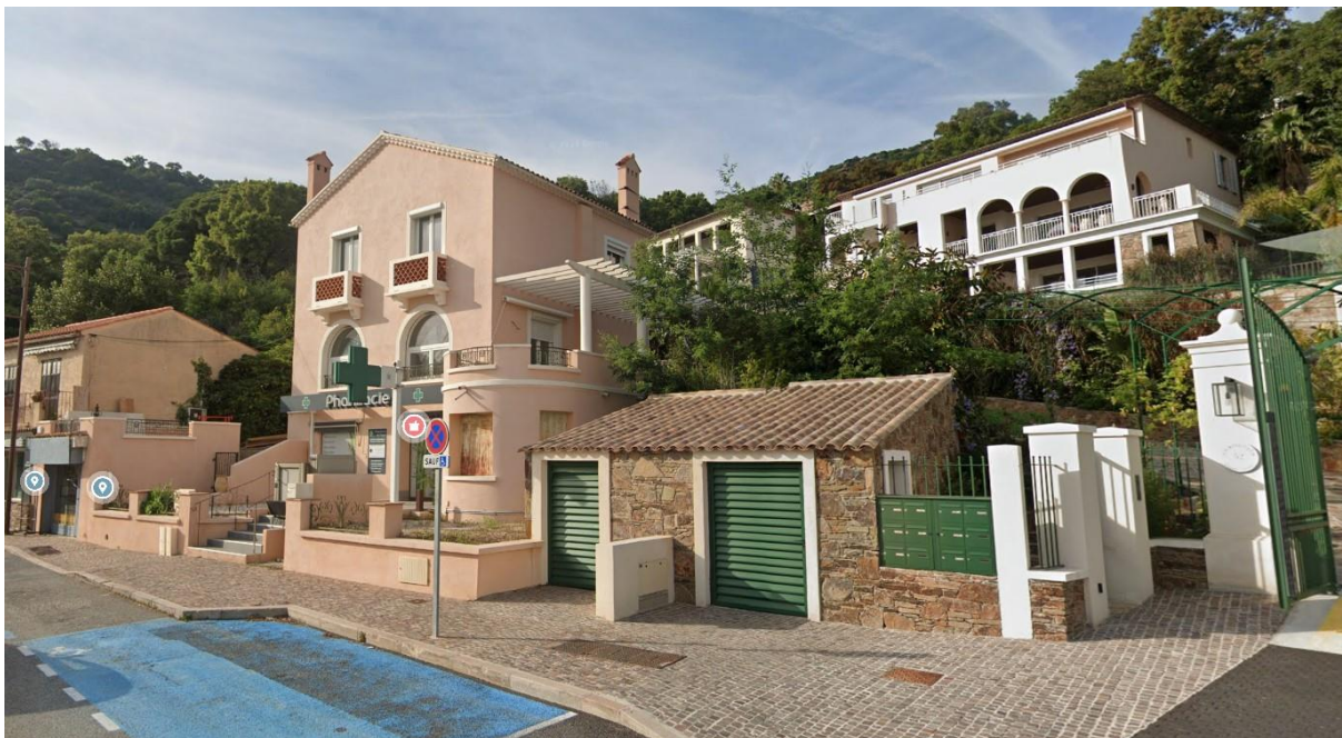
Façade nord de l'av. Etienne Gola en venant de l'Ouest : la pharmacie en rez-de-chaussée est surélevée de 2 étages de logements. En arrière plan le nouveau immeuble collectif en R+ 2 (porte le n°1 sur la photo aérienne en page précédente).
