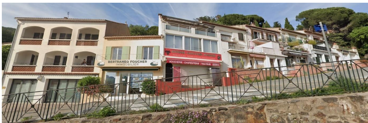
Vue du front bâti de la avenue Mistral, les rez-de-chaussées commerciaux sont surélevés d'un ou de deux étages de logements.
