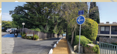
AV. DE FRANCE ET AV. Dr RATYNSKI > Réfection des enrobés > Délimitation des zones piétonnes > Nouveaux marquages au sol
