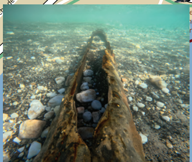
PLAGE DU CANADEL > Réparation de l'émissaire d'assainissement
