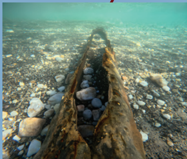
PLAGE DU CANADEL > Réparation de l'émissaire d'assainissement
