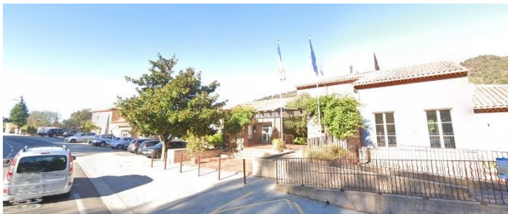
Avenue du Général Bouvet au niveau de la mairie
